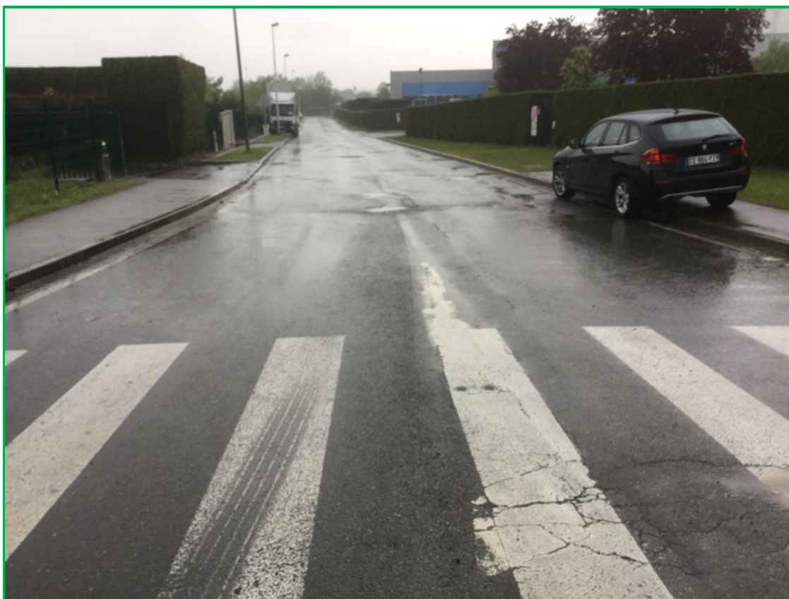
Purge superficielle 15m2
