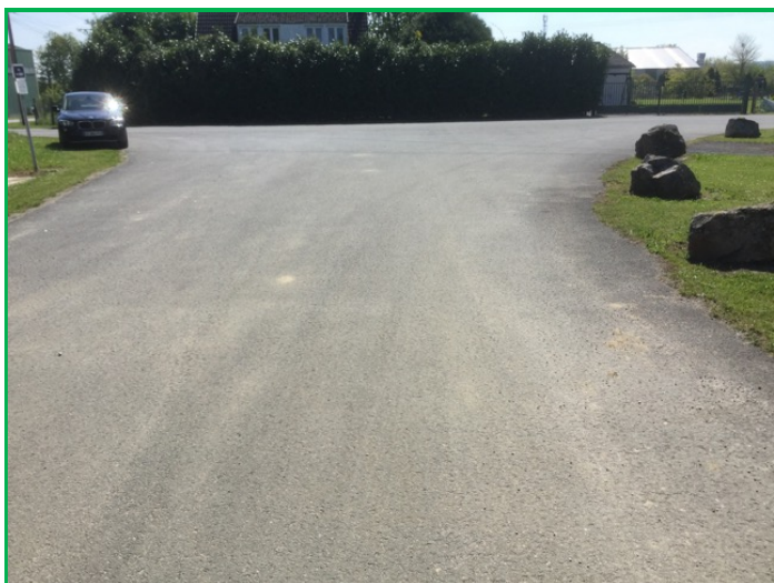
Patte d'oie d'entrée traitée en enrobé
