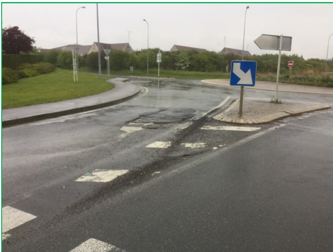
Purge profonde 30m2
